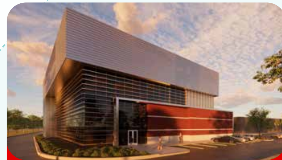
Red Rum Data Center VIRGINIE, ÉTATS-UNIS
